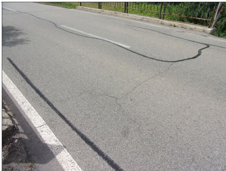
Trhliny ve vozovce
