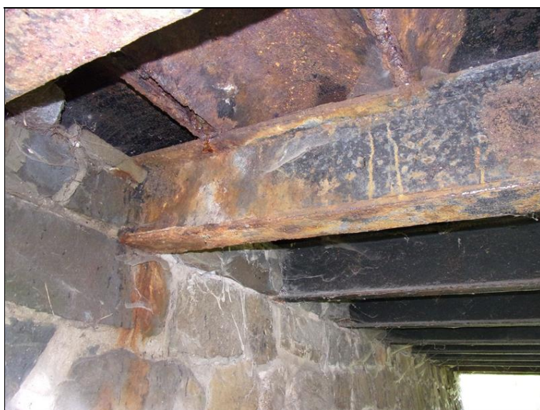
Koroze krajních nosníků
