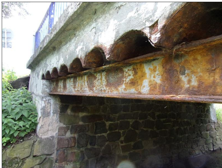
Boční pohled na korozi napadenou ocelovou část NK
