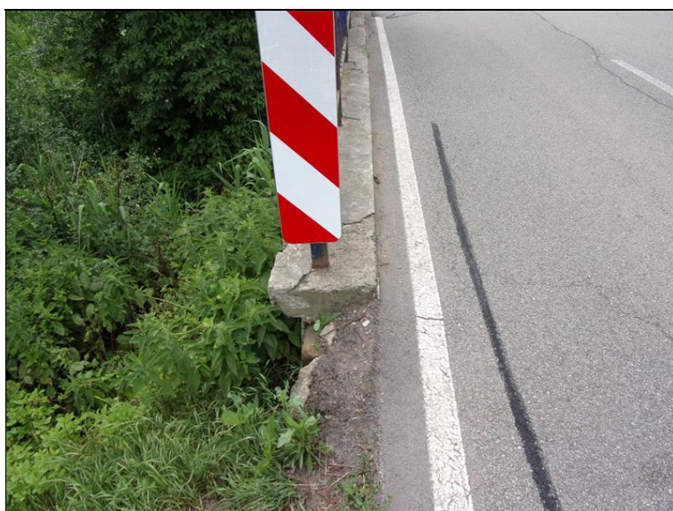
Chybné napojení řimsy na krajnici
