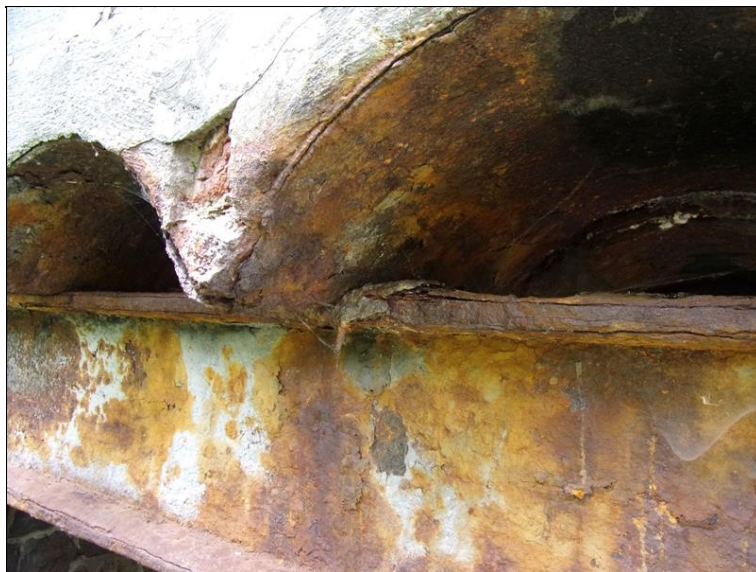
Koroze ocelových příčníků
