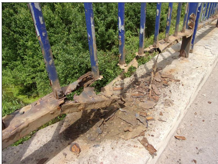
Rozpad zkorodovaného zábradlí
