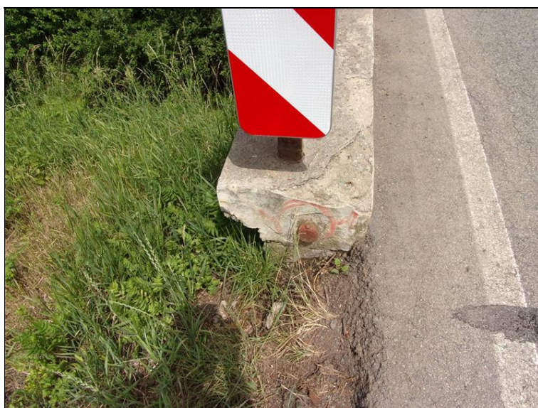
Chybné napojení římsy na krajnici, nivelační bod na pravé římse u OP2
